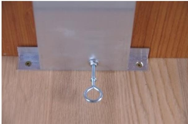
En bas, fixation dans le plancher avec des vis 3,5 x 25.
